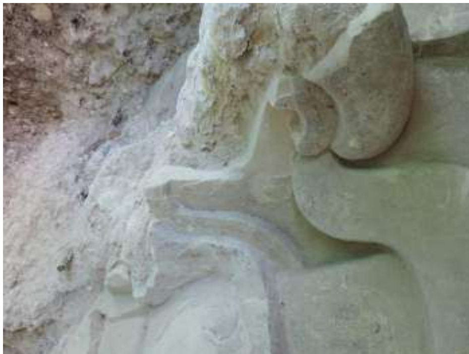
Figura XV-4: Detalle de la consolidación de unos elementos por medio de resanes y ribetes (Fotografía por Teresa Navarro Gómez).
