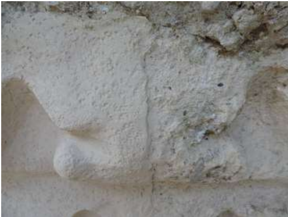
Figura XVI-11: Detalle del recubrimiento imitando la textura original (Foto Teresa Navarro Gómez, 2014).
