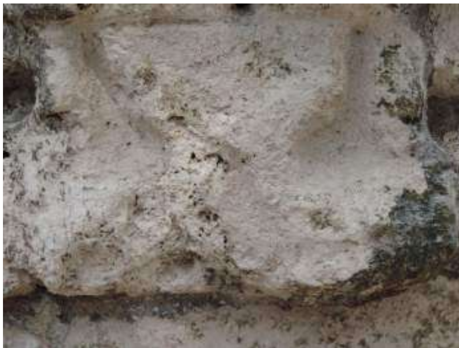
Figura XVI-7: Detalle del fenómeno de disgregación de la piedra caliza tras la eliminación del cemento (Foto Teresa Navarro Gómez, 2014).
