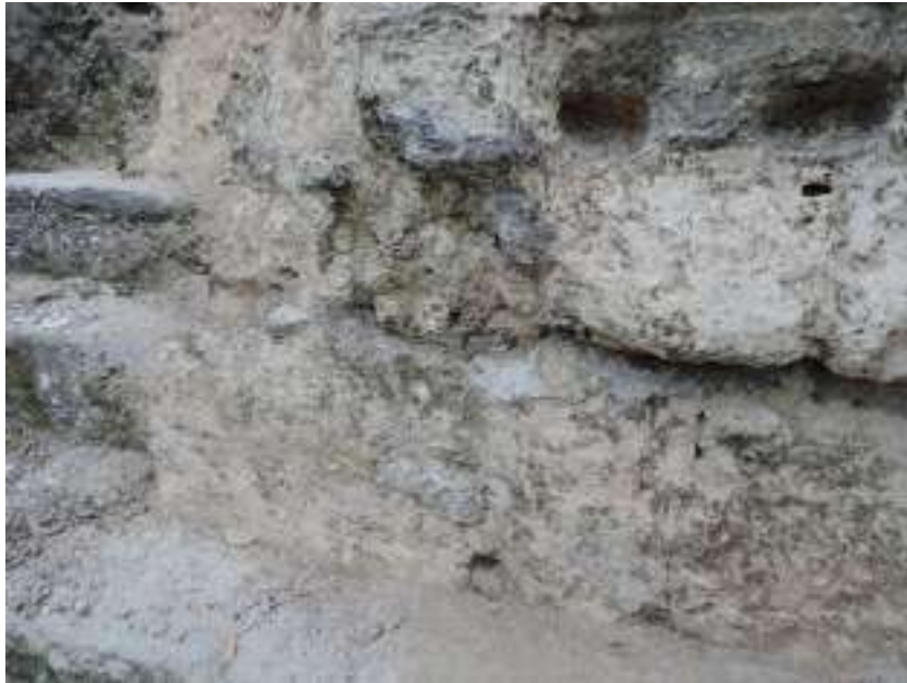
Figura XVI-6: Detalle del cemento tras la eliminación de la capa de microorganismos. (Foto Teresa Navarro Gómez, 2014)
