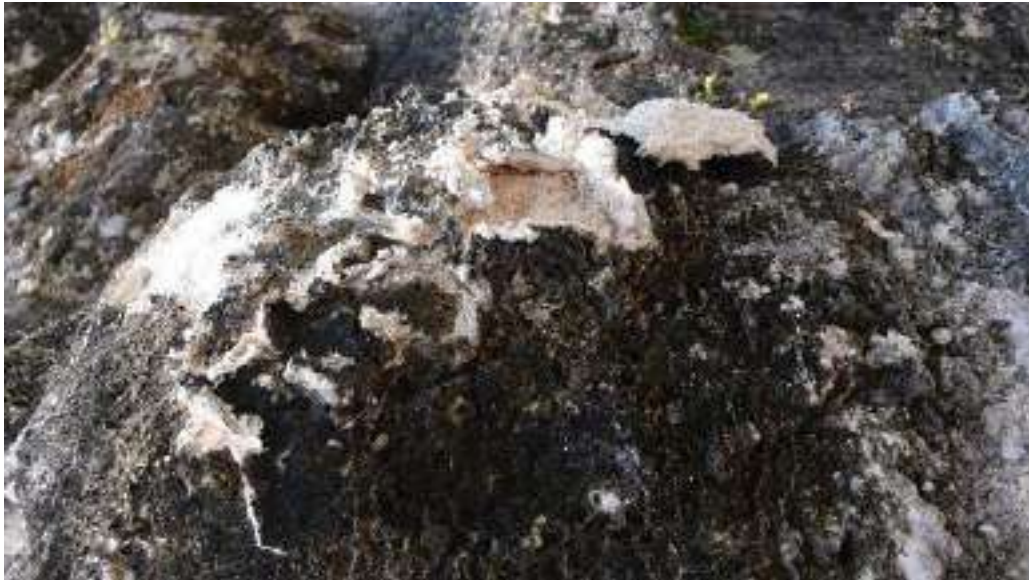
Figura XVI-4: Detalle de la costra negra con una posible reacción de sales solubles creando sub-eflorescencias. (Foto Alice Desprat-Drápela, 2013)
