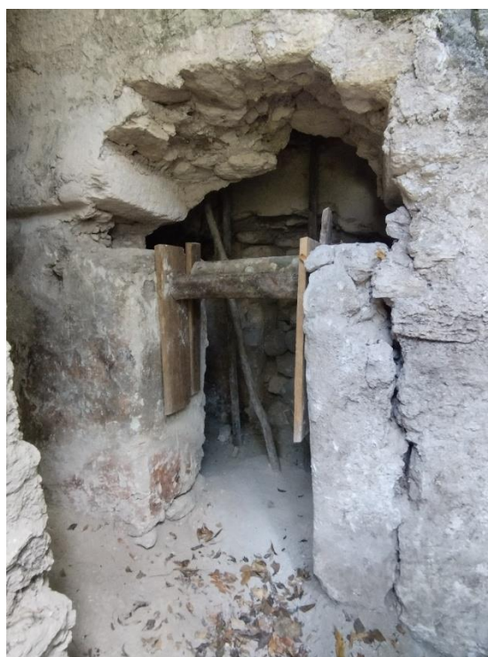
Figura VI-12: Saqueo que expuso de manera fortuita el acceso que conectaba la habitación occidental y la oriental de A-I Sub-1a; esta intervención dañó y destabilizó dicha conexión, por lo que se adoptaron medidas para su estabilización.
