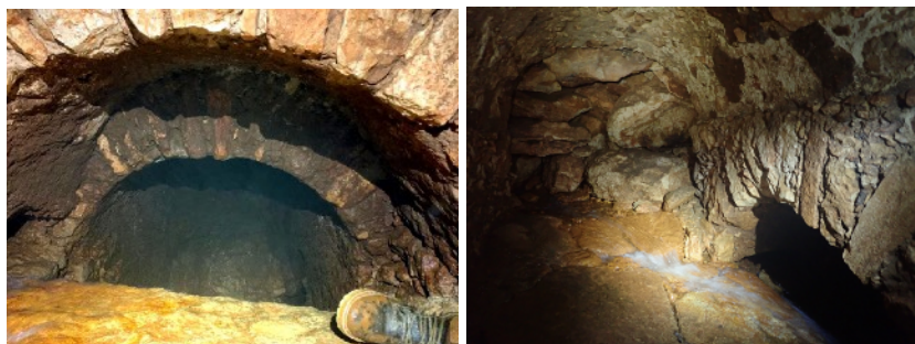
Figura 8. Vista de los dos arcos ubicados en la zona donde escurre el agua. Figura 9. Escorrentía de agua que desemboca en el túnel hasta el desagüe hídrico.
