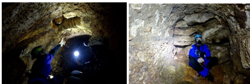
Figura 6. Dovelas expuestas en el techo que le dan forma al arco de medio punto. Figura 7.- Sección del túnel que se encuentra tapiado con grandes piedras.
