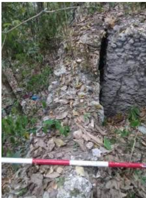
Figura XVI-20. Muro de la Estructura RNE21-I (Fotografía Tomás Drápela).
