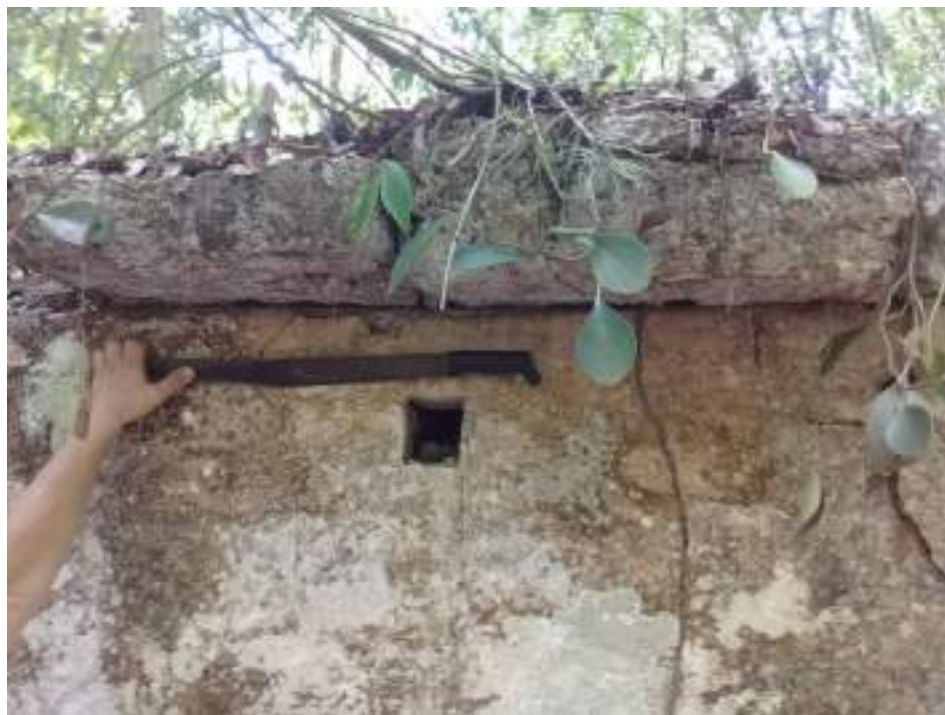
Figura XVI-10. Fachada superior y cornisa preservadas de la Estructura RNE22-II, la escala es un machete de 70 cm de longitud (Fotografía Tomás Drápela).
