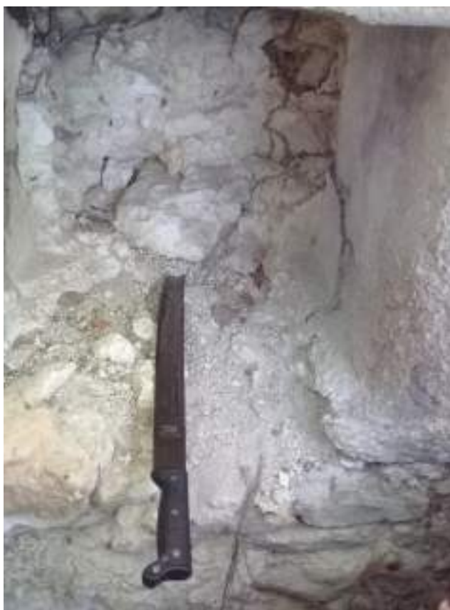
Figura XVI-13. Nicho interior de la Estructura RNE22-I con restos de estuco. La escala es un machete de 70 cm de longitud (Fotografía Tomás Drápela).
