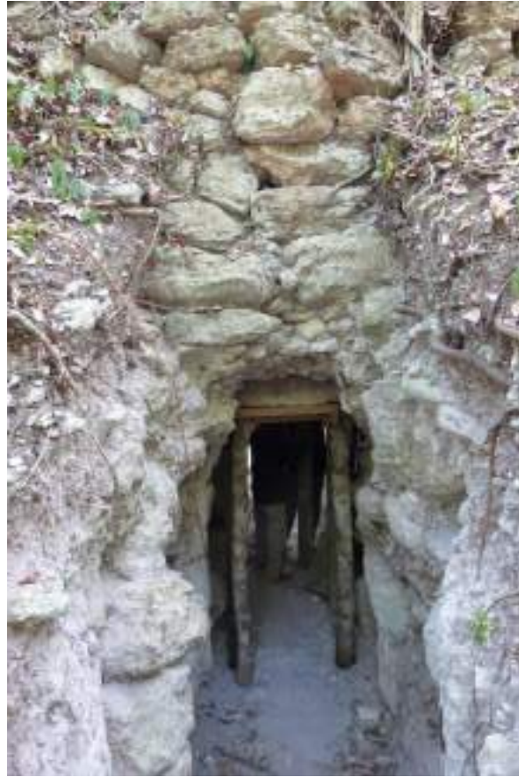
Figura IX-27. Op. 49 Sub. A-X1, detalle del muro en talud de la 6ta. etapa constructiva, nótese el apuntalado en la entrada del túnel de saqueo (Fotografía Julio Cotom).
