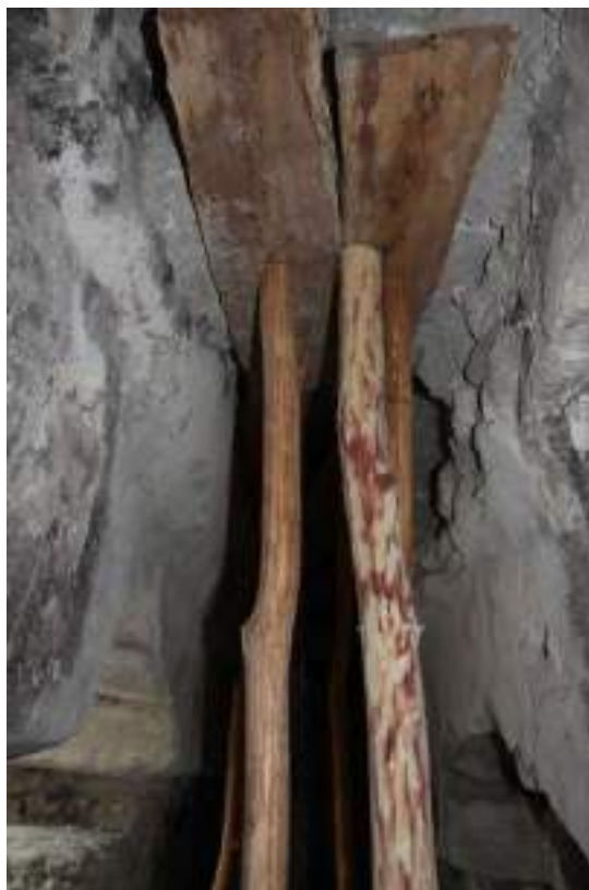
Figura XIV-14: Tablas y postes de madera refuerzan la bóveda del Cuarto 2 de la Estructura A I Sub-1 (Foto por Felix Kupprat).
