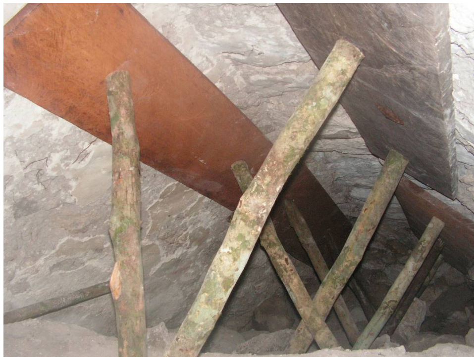
Figura III-92: Sistema de soportes construido para proteger la Casa de las Pinturas (fotografía por M. Kováč).
