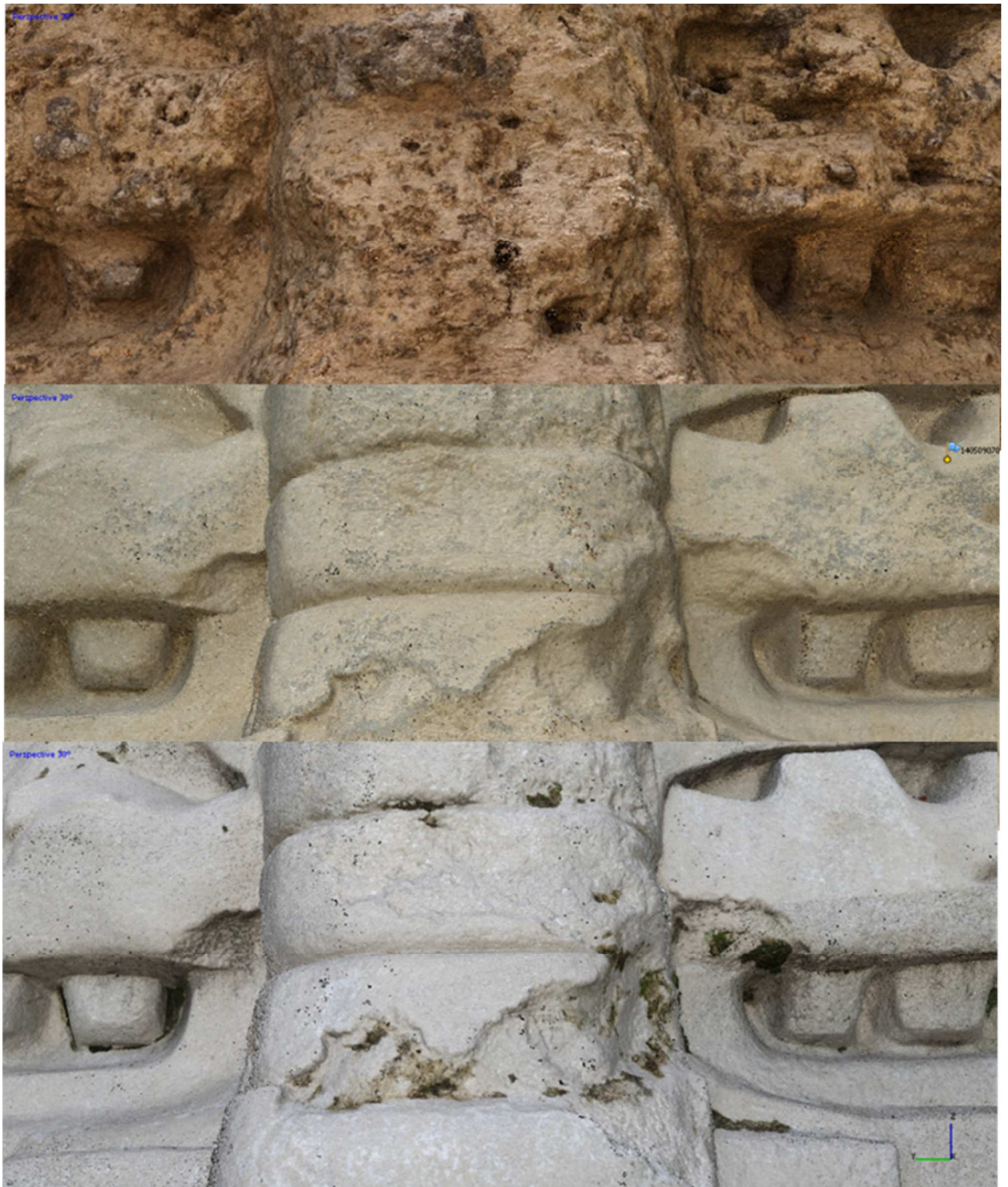
Figura X-4: Monitoreo detallado de los cambios de una parte de un mascarón con base en la sección de la nube de puntos. Antes de los trabajos de restauración; inmediatamente después de la intervención de restauración; un año después de la intervención. (Proyecto Arqueológico Regional Uaxactun).
