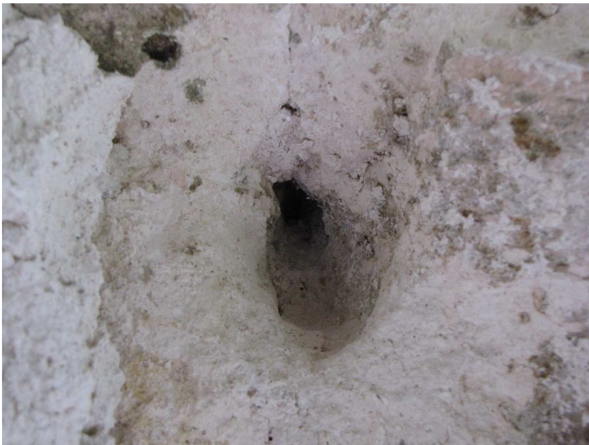
Figura IX-8. Cavity por impacto de bala calibre 40mm (Foto por E. Zambrano).
