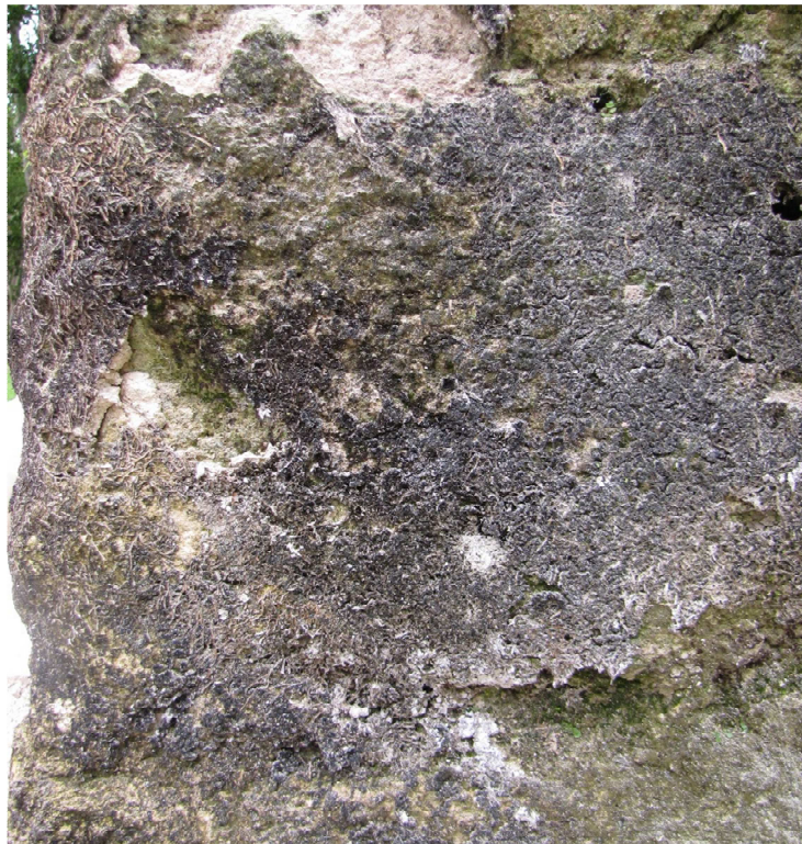
Figura IX-3: Bio-costra y posible reacción de sales solubles provocando sub-eflorescencia (Foto por E. Zambrano).
