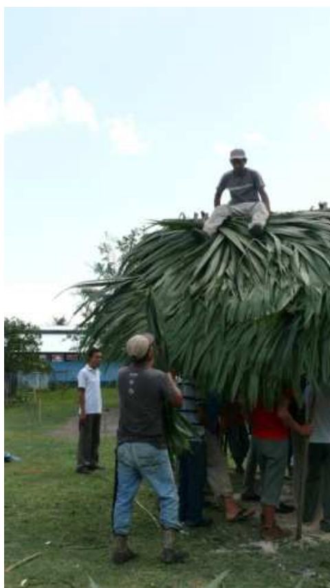
Figura XIII-6: Trabajadores del Proyecto Arqueológico Uaxactún construyendo un techo (Foto: Xol Choc. 2016).
