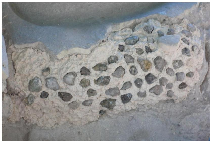
**Figura II-25:** Aplicación del mortero grueso con piedritas durante los procesos de reintegración de la mejilla derecha del mascarón Norte (fotografía por A. Desprat).
