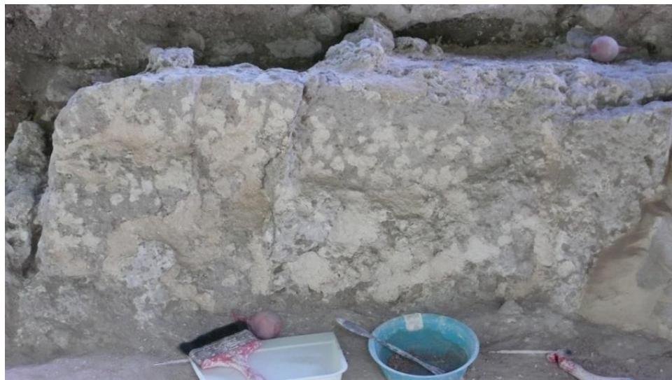
**Figura II-18:** Resane de las cavidades de las piedras de soporte presentando fenómenos de alveolización (fotografía por A. Desprat).
