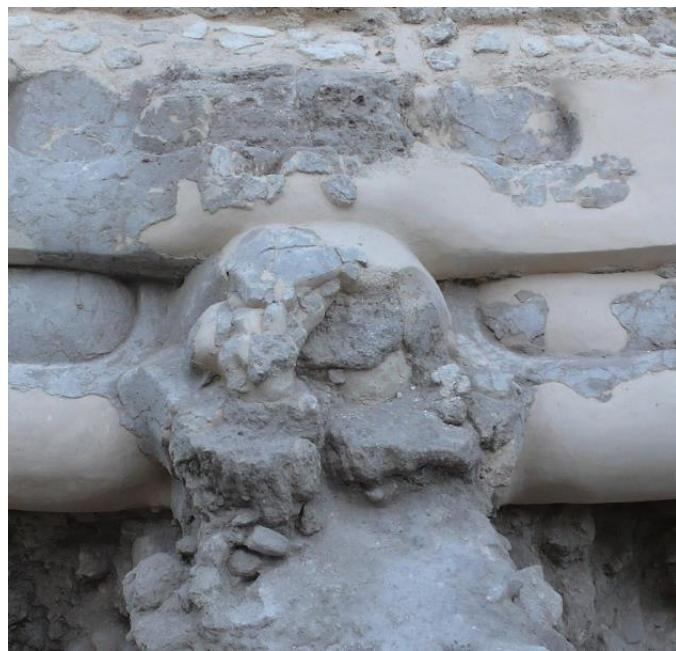
**Figura II-35:** Vista de la nariz del mascarón Sur después de la intervención de remoción de los fragmentos desplazados (fotografía por A. Desprat).
