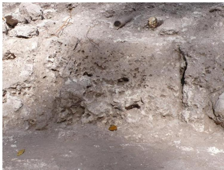
**Figura II-6:** Fenómenos de alveolización y microkarst en las piedras (fotografía por A. Desprat).
