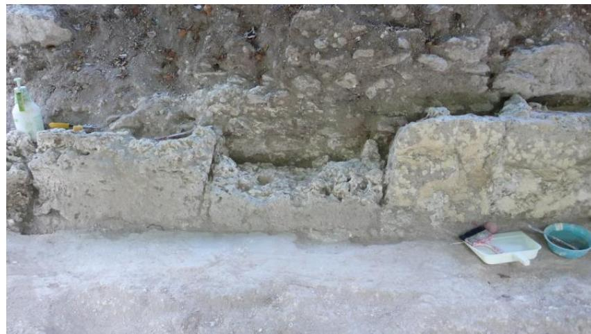
**Figura II-21:** Durante la reintegración de las piedras de soporte del lado Norte (fotografía por A. Desprat).
